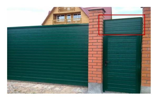
изготавливаются на базе калиточных профилей
