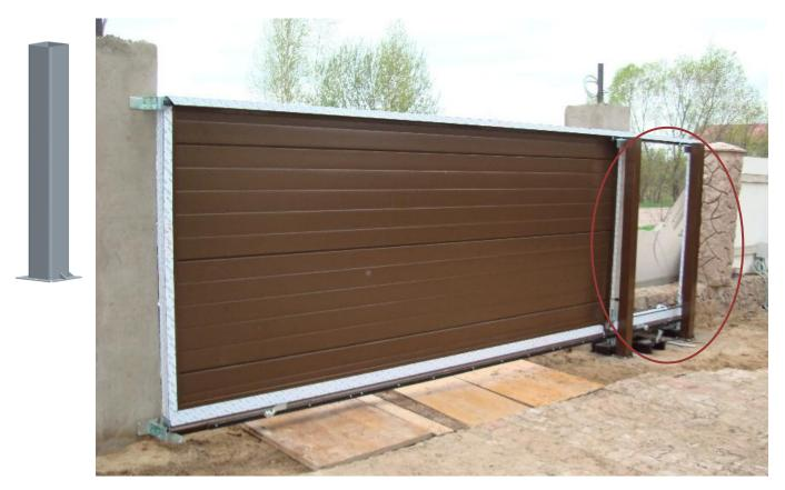
До ширины проема 3500мм устанавливается 1 столб.
