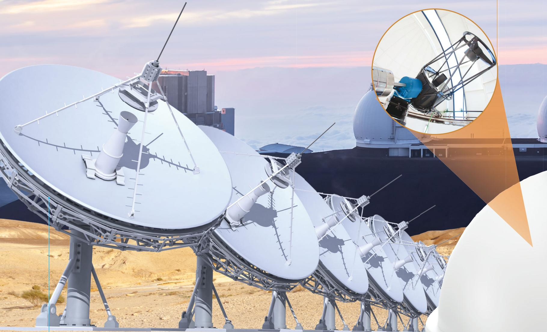
Радиотелескопы — это младшие братья обычных спутниковых антенн: принцип действия похож, но размеры отличаются. Диаметр крупнейших тарелок превышает размеры футбольного поля. Например, радиотелескоп «Грин-Бэнк» в США имеет диаметр 110 м и площадь почти 8 тыс. м<sup>2</sup>.
