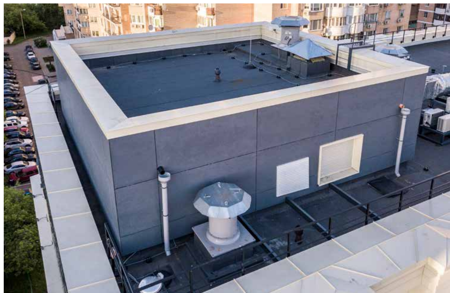
Бизнес-центр «Грузинка 30» Адрес: Ул. Б. Грузинская 30, стр. 1, Москва
