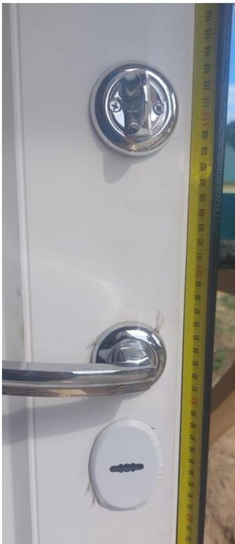
Как правило, и в этом случае можно установить электронный замок на старую мортизу, при условии, что расстояние от центра ручки до центра замочной скважины составляет около 88 мм. В этом случае можно просверлить отверстие в старой мортизе, не нарушив целостности ее механизма.
