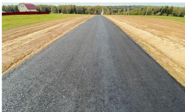
Устройство дорог в КП Северный Берег Дмитровский район
