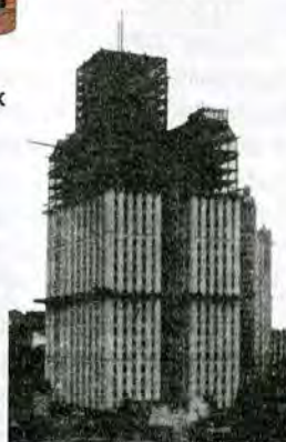
Строительство небоскреба в Нью-Йорке. (Новые изобретения – стальные балки и лифт)
