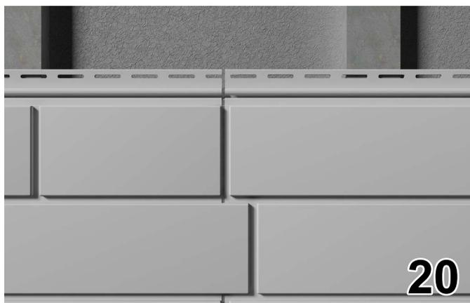
Когда Вы достигнете верха стены, Вам потребуется подрезать панели, устанавливаемые в последний ряд, по высоте. Отмерьте расстояние от предпоследнего ряда панелей до внутренней части универсального J-профиля 7/8" и вычтите из результата замера 5-7 мм. Отрежьте верхнюю часть панели руководствуясь полученными вычислениями. Вставьте подготовленную панель в замок нижней панели. Слегка согнув панель вставьте ее в универсальный J-профиль 7/8".
