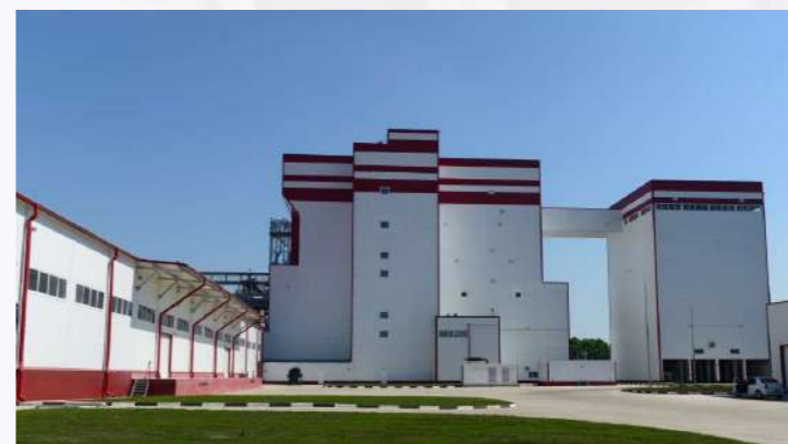
Внешний вид объекта
