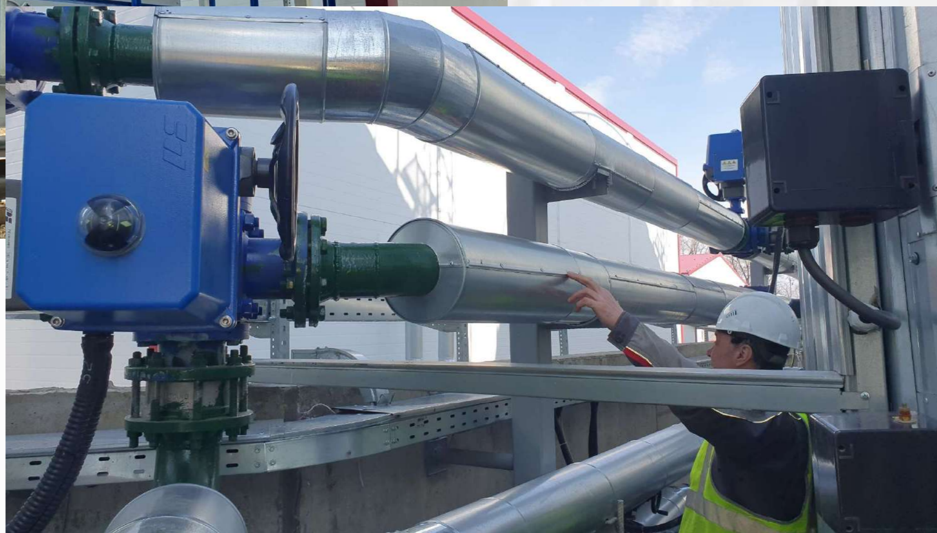
Затвор с электроприводом
