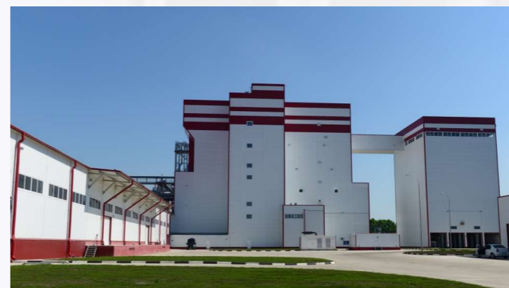
Внешний вид объекта
