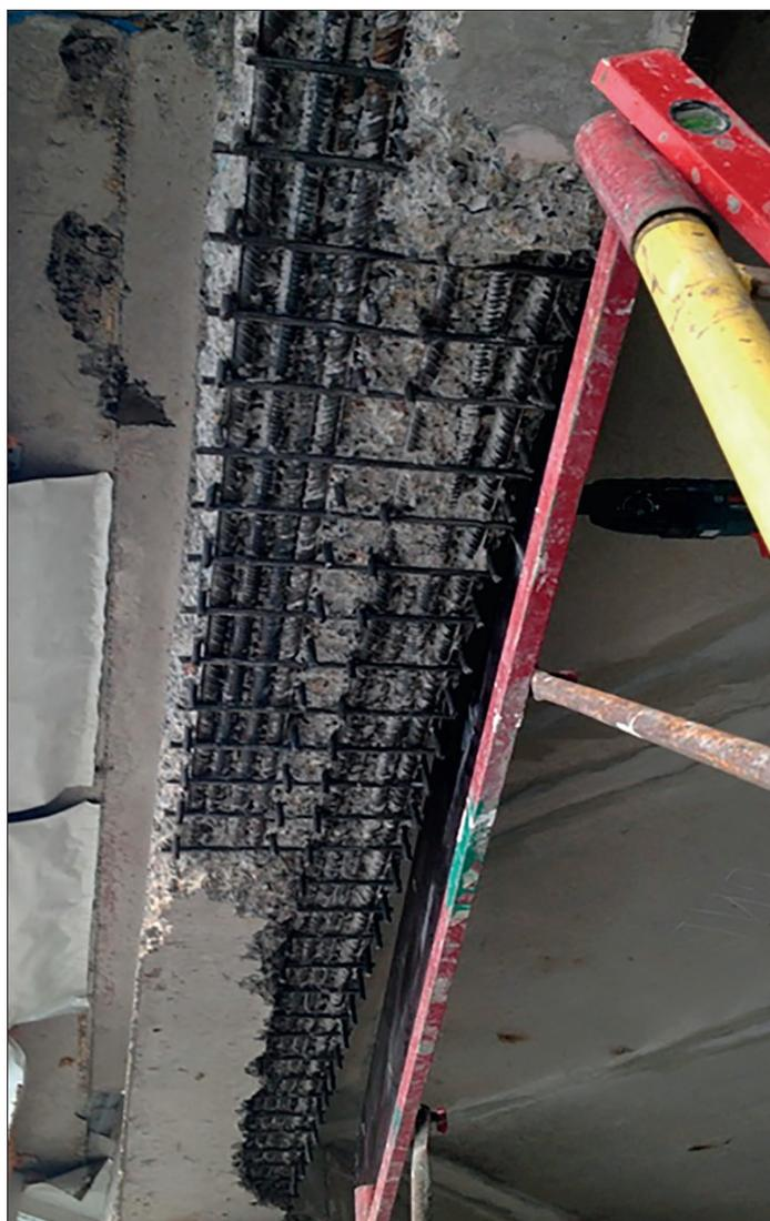
Рисунок 9 – Монолитные участки железобетонных балок с участками оголенной арматуры
