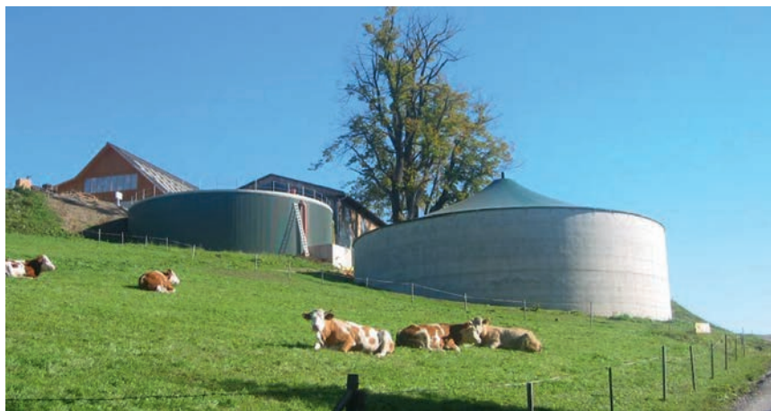
Рисунок 4.5.5 – Готовые биореакторы из монолитного железобетона
