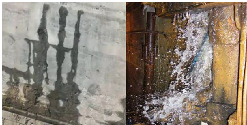
Рисунок 6.2.1 – Безнапорная и напорная течи
