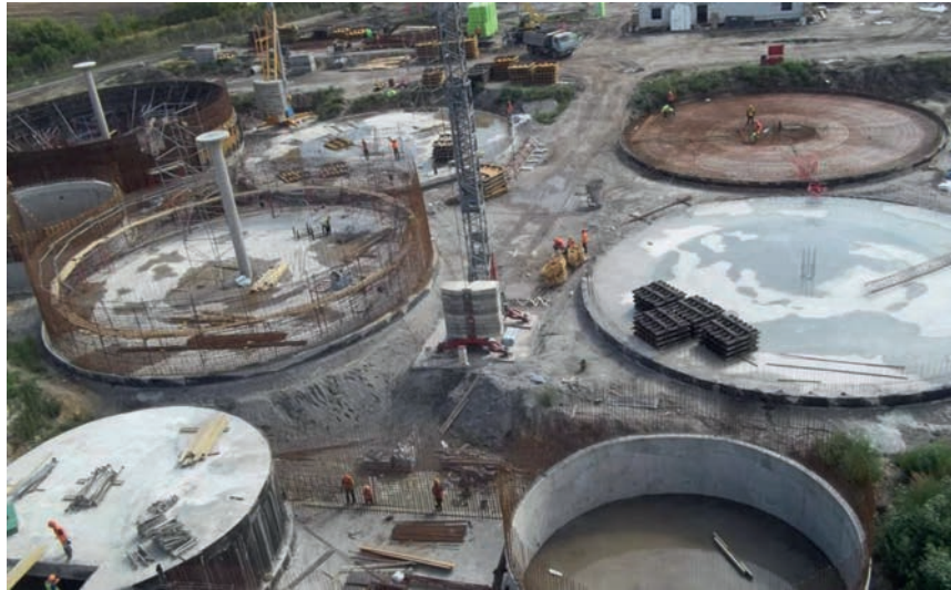
Рисунок 4.5.4 – Строительство биогазового комплекса
