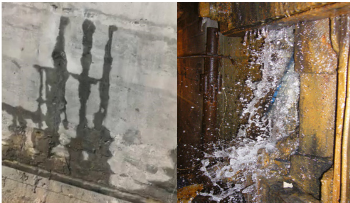
Рисунок 8.2.1 — Безнапорная и напорная течи
