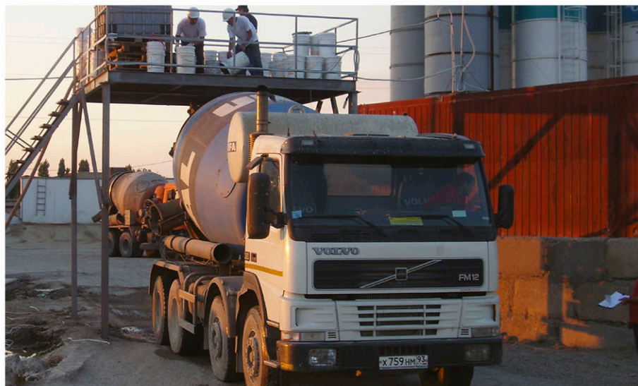
Рисунок 7.1.2 – Пример введения добавки «Пенетрон Адмикс» в автомиксер.
