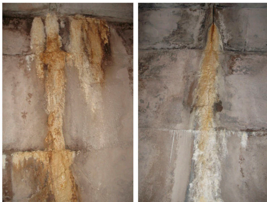
Рисунок 6.7.2 – Транспортно-кабельный туннель: а – выходной оголовок туннеля; б – фильтрация воды через стены туннеля с выносом свободной извести и продуктов коррозии арматуры.
