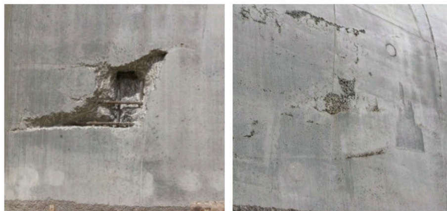
Рисунок 6.8 - Напорные водоводы гидроаккумулирующей станции: а – панорама строительства водоводов; б – дефектные участки бетона на поверхности водовода.
