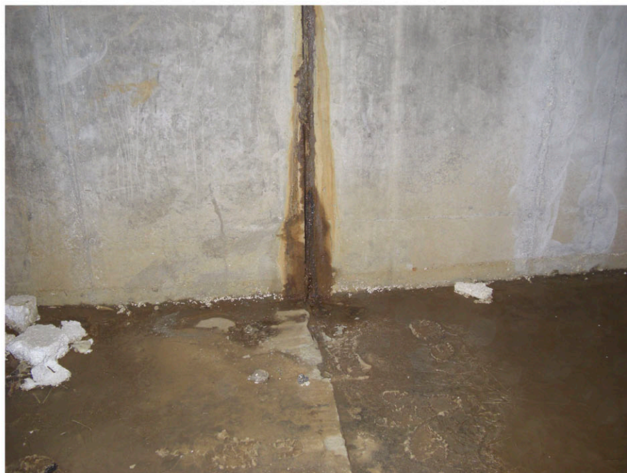
Рисунок 7.2.35 - Безнапорная течь.
