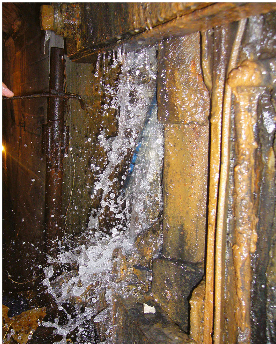
Рисунок 7.2.36 - Напорная течь.
