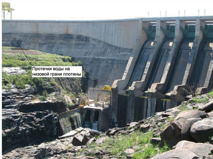
Рисунок 6.2.1 - Плотина из укатанного бетона.
