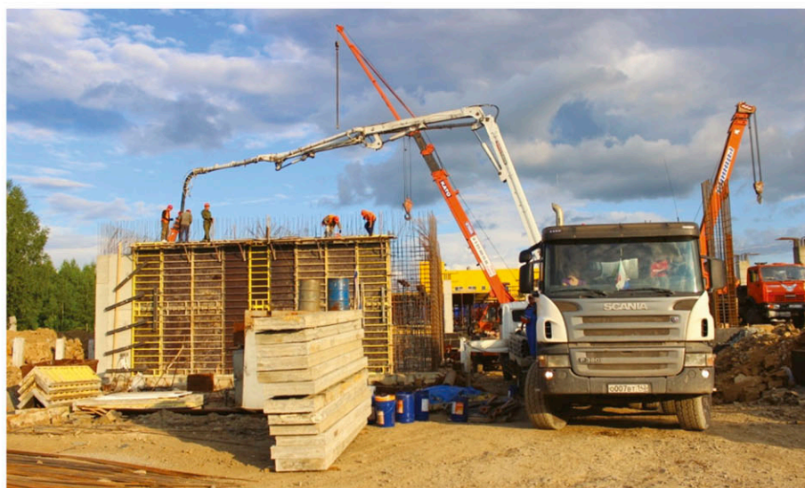
Рисунок 7.1.4 - Подача бетонной смеси в опалубку.
