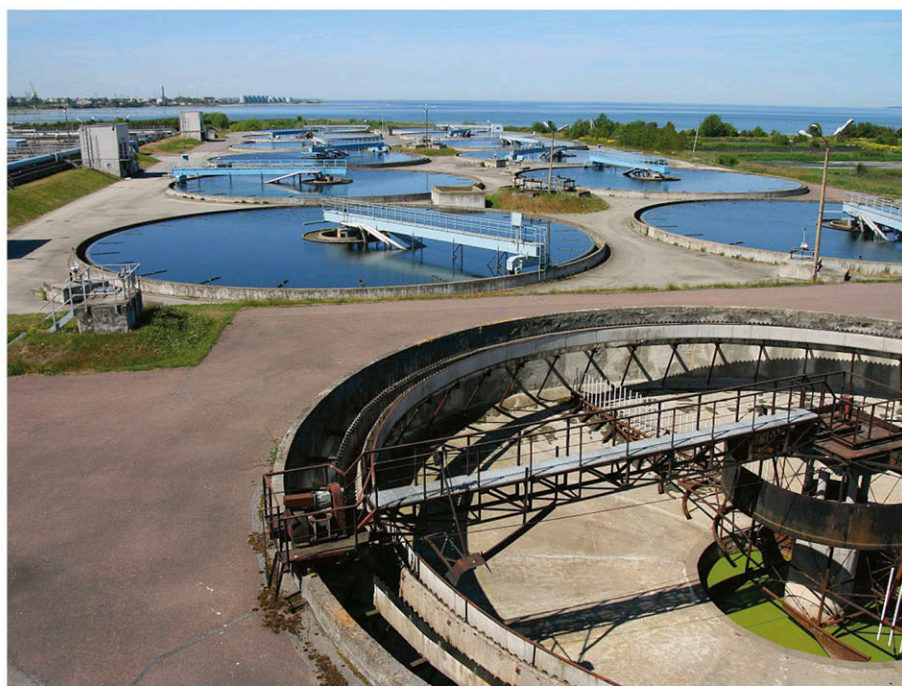
Рисунок 6.4.1 - Радиальный отстойник из монолитного железобетона.
