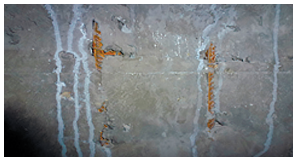
Недостаточная толщина защитного слоя
