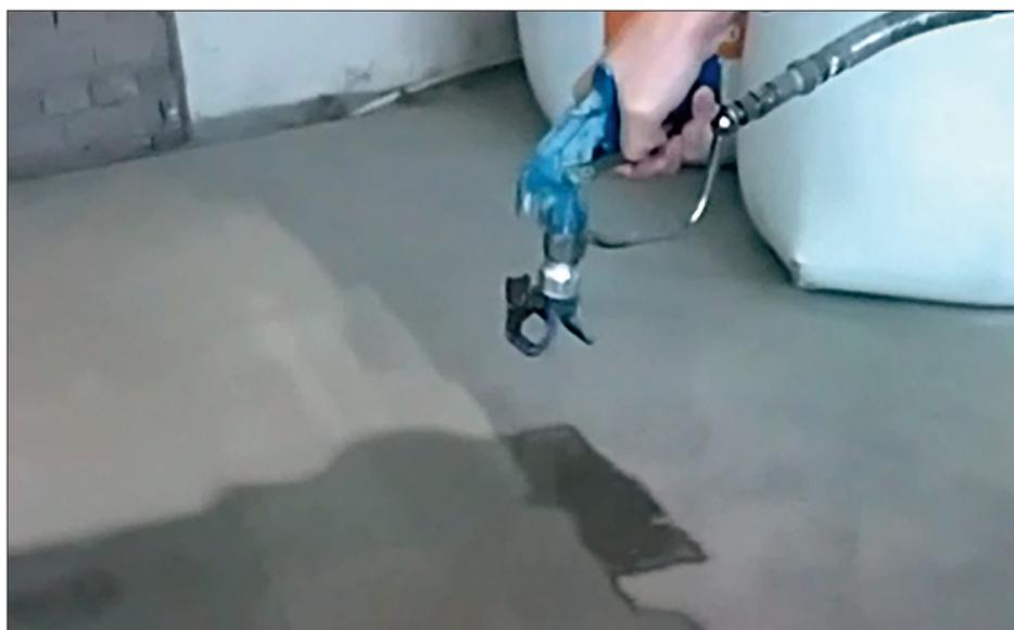
Рисунок 26 – Нанесение растворной смеси «Скрепа 2К Эластичная» аппаратом безвоздушного распыления
