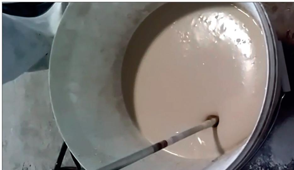
Рисунок 25 – Приготовление растворной смеси «Скрепа 2К Эластичная»
