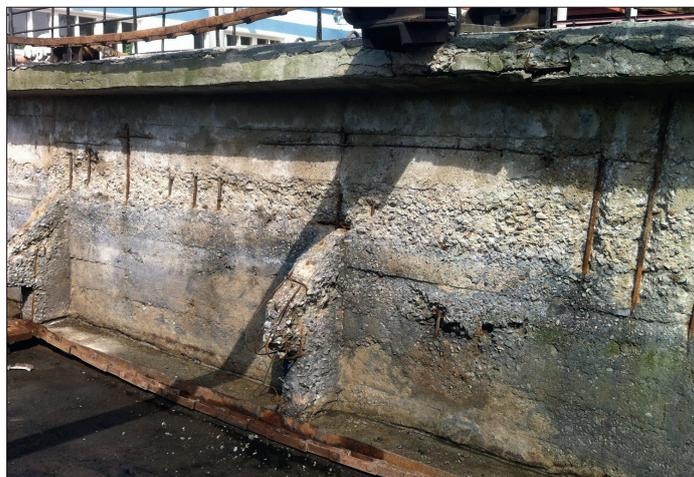
Рисунок 4 – Разрушенные участки бетона с оголенной арматурой
