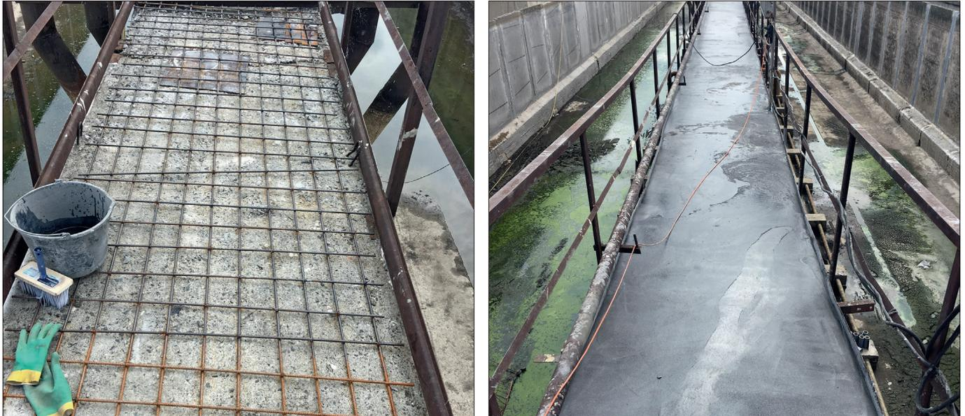
Рисунок 17 – Ремонт плит переходных мостиков (соотношение по массе: «Скрепа М600 Инъекционная»:Песок = 1:1)
