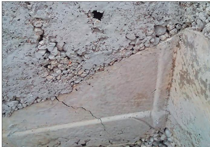
Рисунок 3 – Поверхностные дефекты бетона
