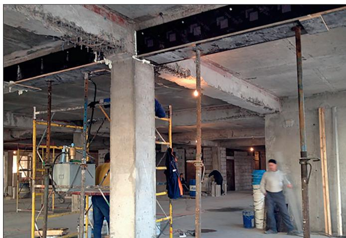
**Рисунок 11 – Установка опалубки**
