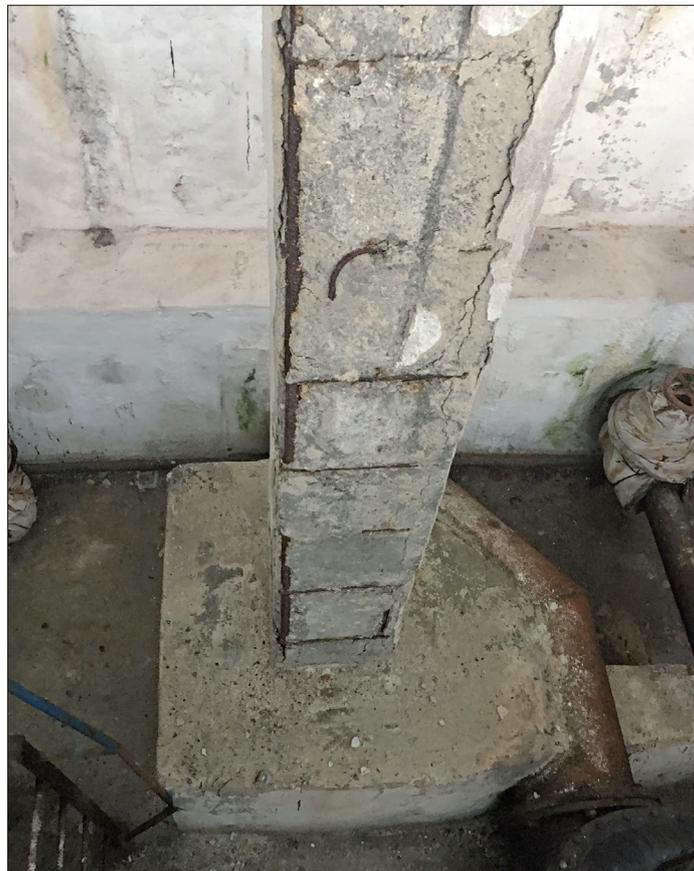
**Рисунок 7 – Несущие железобетонные колонны с поврежденным защитным слоем бетона и участками оголенной арматуры**
