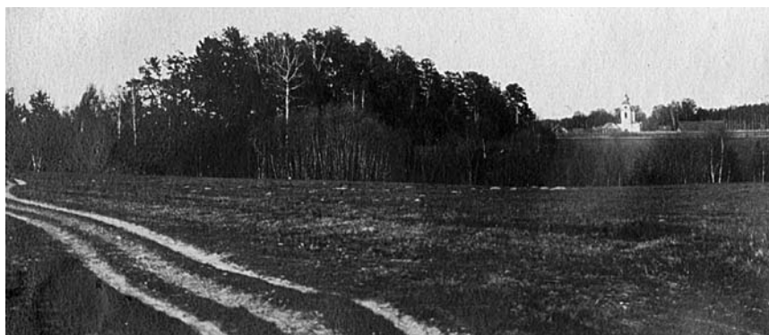
Вид на Спасскую церковь с. Каблуково. Фотография ок. 1909 г.
