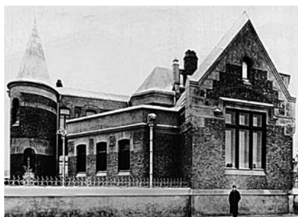
Южный фасад дома Ф. Шехтеля в Ермолаевском пер., д. 28., 1896 г. постройки.
