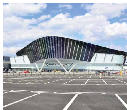
Конгресс-Холл, Екатеринбург-ЭКСПО, г. Екатеринбург
