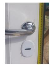
Как правило, и в этом случае можно установить электронный замок на старую мортизу, при условии, что расстояние от центра ручки до центра замочной скважины составляет около 100 мм. В этом случае можно просверлить отверстие в старой мортизе, не нарушив целостности ее механизма.
