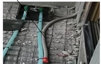
**датчик температуры терморегулятора, к трубе или отступив от трубы системы АСОТ не более 1-2 см.**
