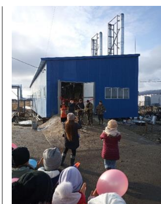
Открытие модульной котельной
