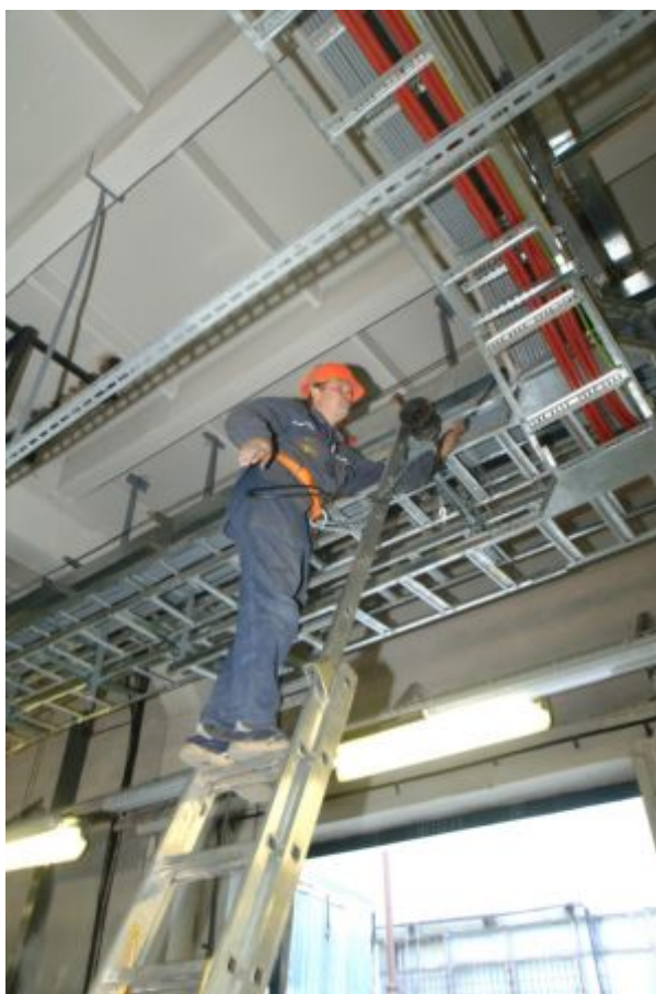
Рисунок 4.7.12 - Монтаж электропроводок на лотках
