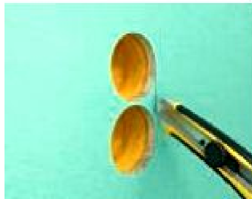
Рисунок 4.9.1 – Высверливание гнезда под установку установочных коробов
