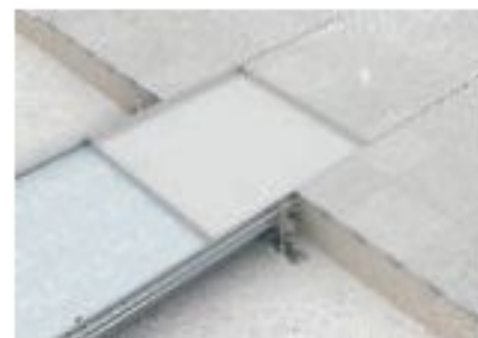
Установить кассетные рамки
