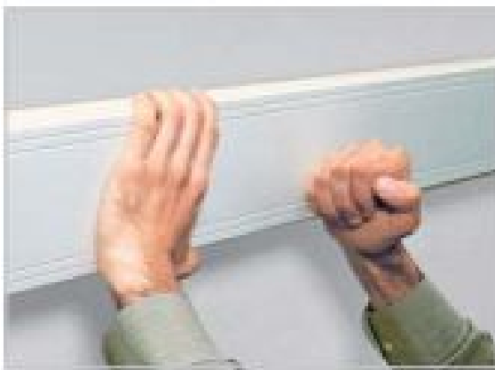
Рисунок 4.6.5 - Установка коробов
