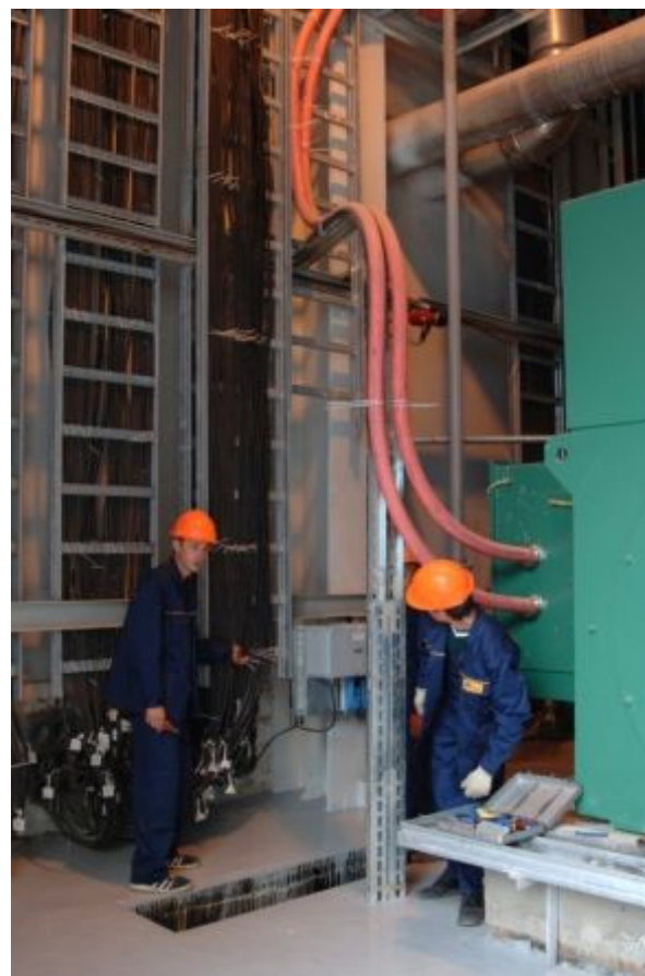
Рисунок 4.7.12 - Монтаж электропроводок на лотках
