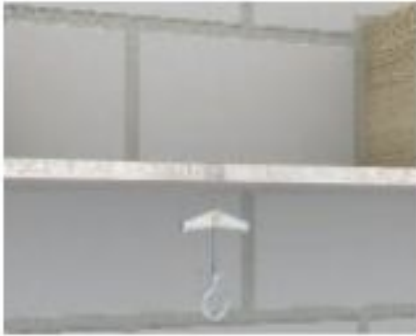
Пружинно-откидной и откидной дюбель Для монтажа на подвесном потолке или в полый стене используются откидной или пружинно-подвесной дюбель.
