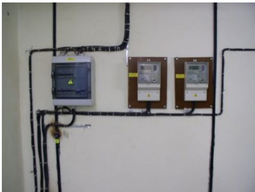
Рисунок 4.3.3 - Электропроводки открыто непосредственно по строительным основаниям
