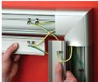
Количество монтируемых проводов заземления в плоском углу
