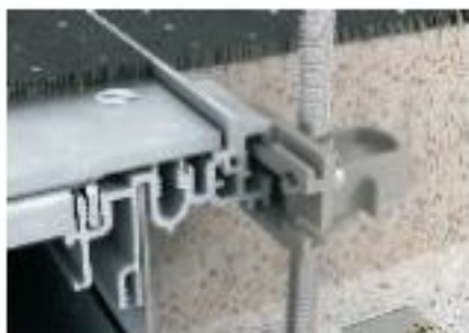
Установка профиля для стыковки с напольным покрытием
