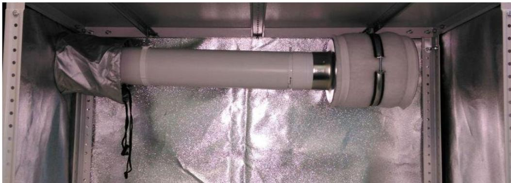
2. Установите в держатели вентиляционную трубу, соединенную с вентилятором.
