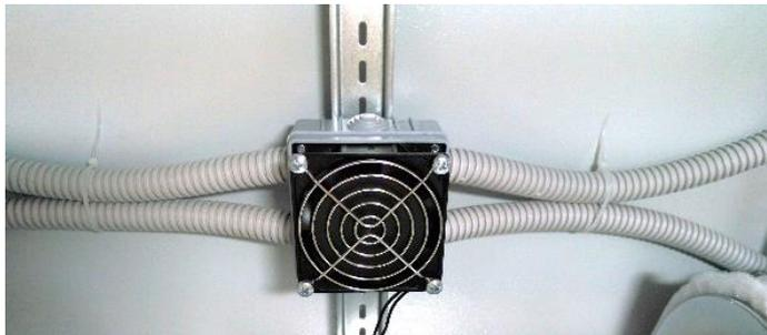
3. Вставьте гофротрубки в отверстия в распределительной коробке.
