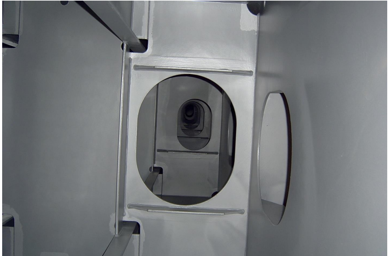
Днищевой блок - район балластного танка - нанесен первый слой и проведена линейная окраска
