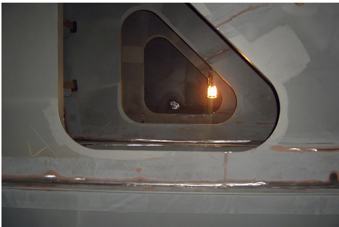
Сборка судна завершена. Очистка сварных швов в балластном танке.
