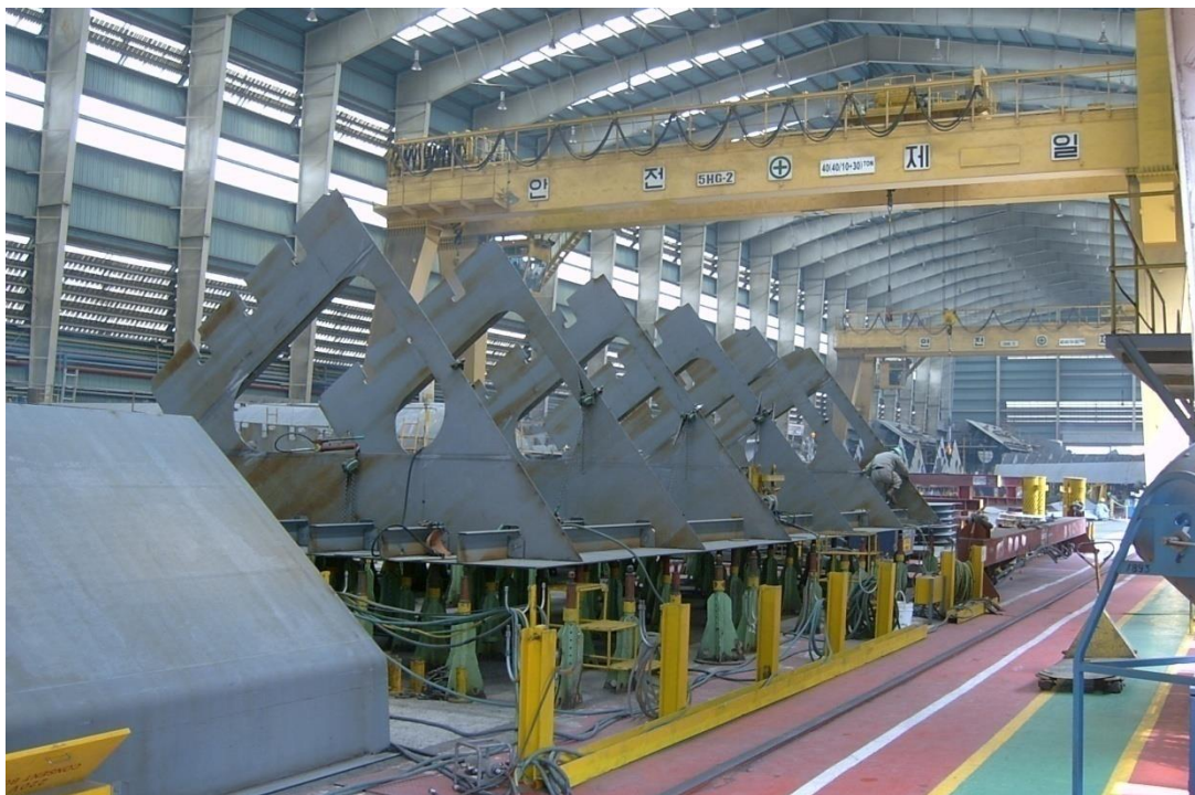
Цех по фабрикации сферических блоков
