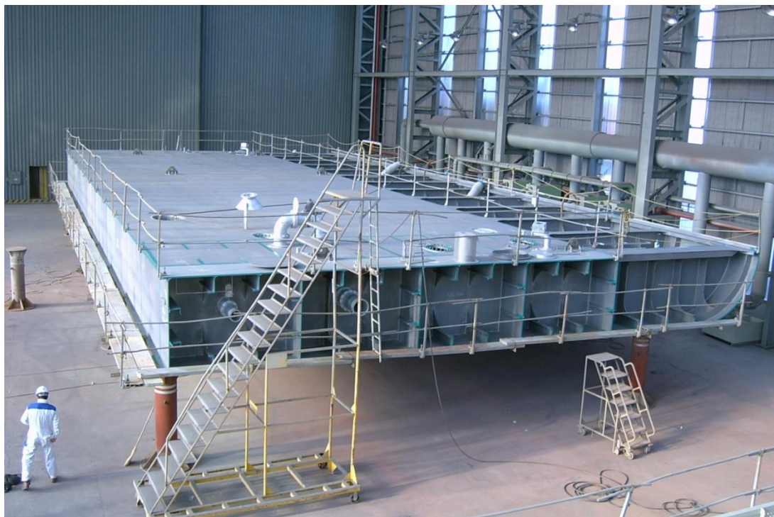
Днищевой блок после дробеструйной очистки в покрасочном цехе
