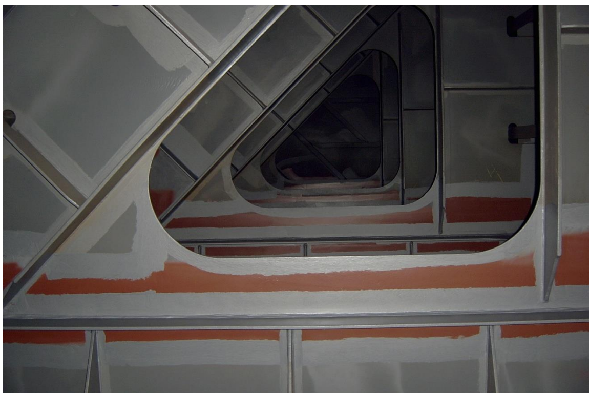
Балластный танк - сварные швы перед нанесением 2-го слоя
