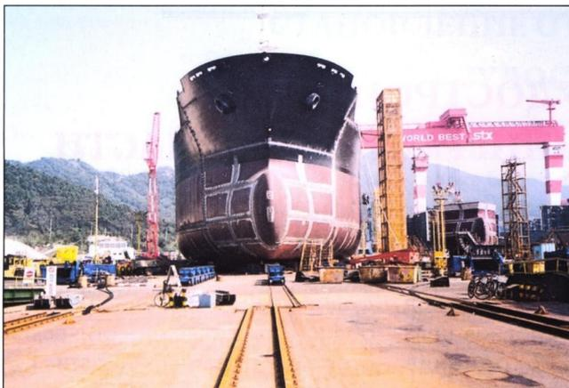
Передвижка судна на тележках в плавдок (на переднем плане)
