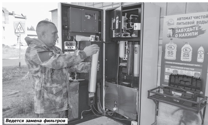
Ведется замена фильтров
