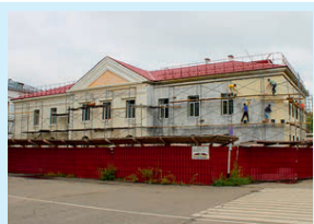
Ремонт ДШИ под трели дрели Стр. 5
