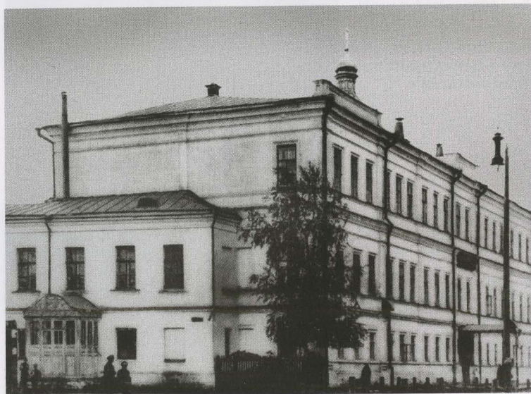
Здание Арзамасского духовного училища. Фото начало XX в.
