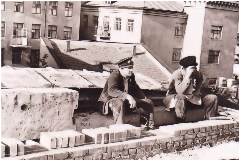
На фото 203: Офицеры дивизии на строительстве жилого дома
