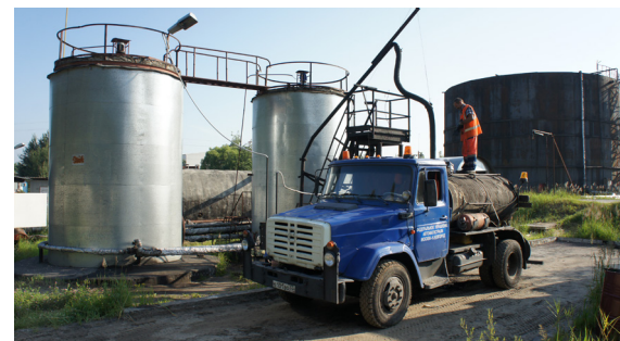
Эмульсионный завод, ДСУ-3 Владимирская область
