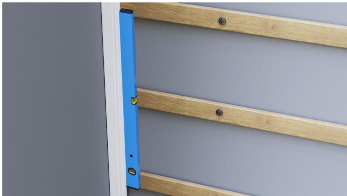
6. Прибейте панель ко всем рейкам на гвозди. Гвозди вбиваются в элемент панели который закрывается следующей панелью.
