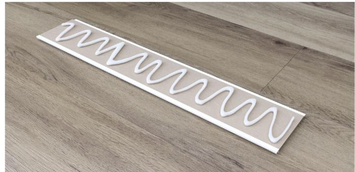
\*Для склеивания модульной панели и стены, используется полимерный клей, который наносится на ее обратную сторону точечно, полосками или в виде «змейки».
