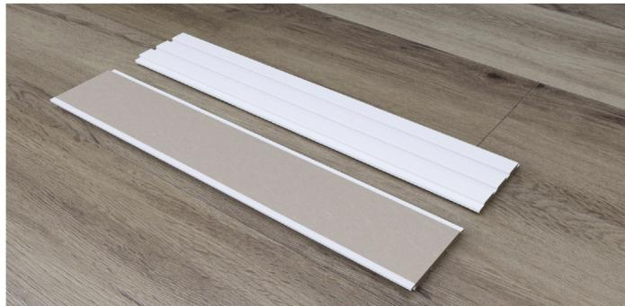
3. Равномерно нанесите клей\* по всей задней поверхности панели.
