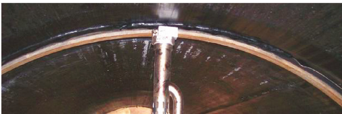
Рисунок 11. Приварка вкладыш-лента ПЭ80 с помощью экструдера
