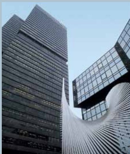
Бесперебойное снабжение высотных зданий
