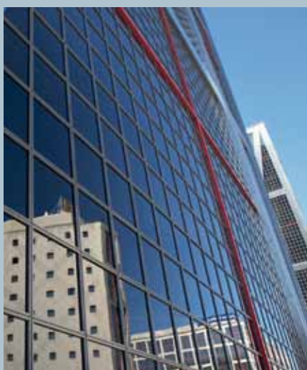
Надежное энергоснабжение компьютерного центра
