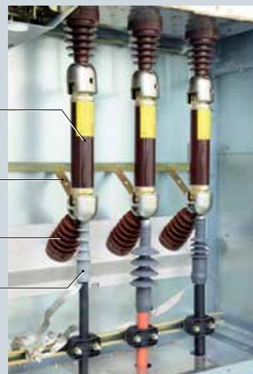
Высоковольтные предохранители в ячейке трансформатора, типа Т вид сбоку
