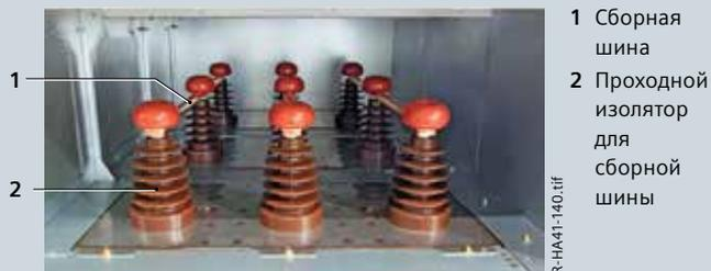
Отсек сборных шин на 3 ячейки
