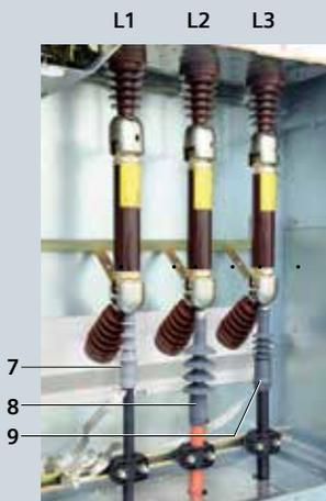
Кабельный отсек с кабельными концевыми муфтами (опции: А<sup>2)</sup>, см. далее)
