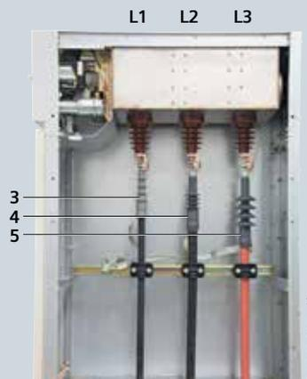
Кабельный отсек с кабельными концевыми муфтами (опции: А, В, С<sup>1)</sup> и D<sup>1)</sup>, см. далее)
