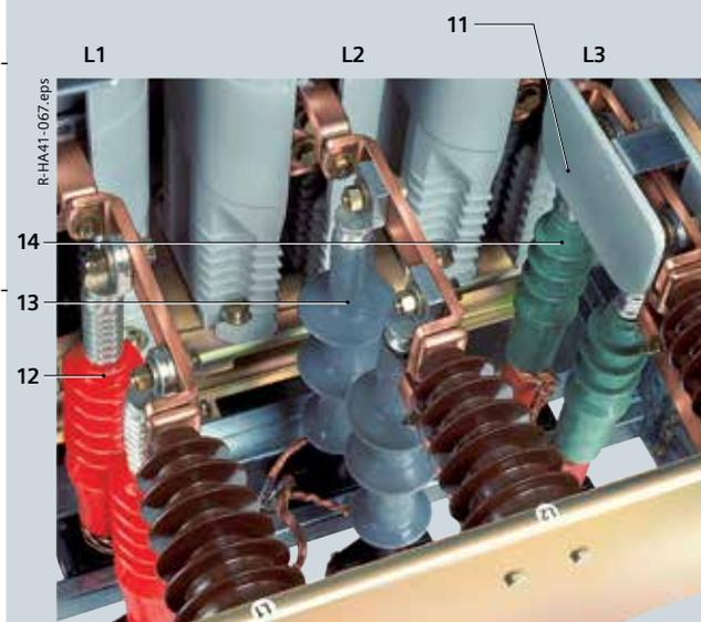
Кабельный отсек с кабельными концевыми муфтами
