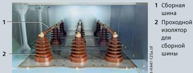
Отсек сборных шин на 3 ячейки
