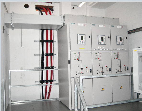
Пример вывода за пределы помещения подстанции
