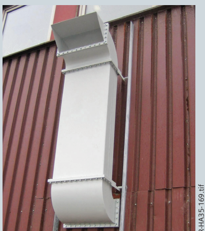
Пример вывода за пределы помещения подстанции
