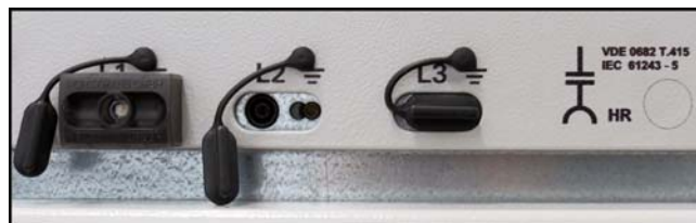
Рисунок 46: Гнезда HR/LRM
