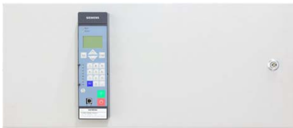
Рисунок 37: Низковольтный отсек с прибором управления и защиты серии SIPROTEC 4
