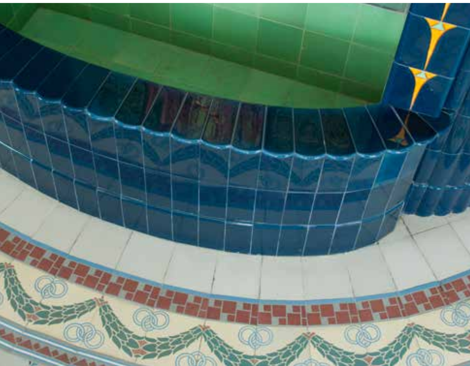
Původní obklady a jejich repliky / Original tiles and replicas arch. Jan Kotěra
