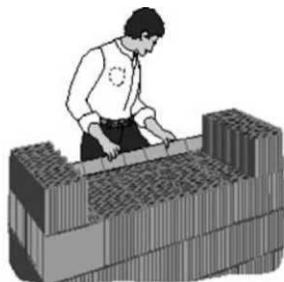
Для проверки вертикального и горизонтального модуля кладки подготовьте прямую оструганную рейку с насечками через каждые 125 мм. Длина рейки должна отвечать запроектированной высоте готовой стены (кратное 231 мм).
