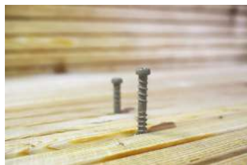
Крепление террасной доски при помощи встроенной системы замков и самореза TER-A
