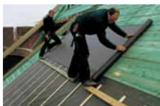
Крыши со сплошным настилом и двухслойной вентиляцией.
