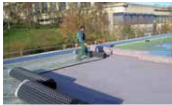
Дренажная мембрана для интенсивного озеленения.
