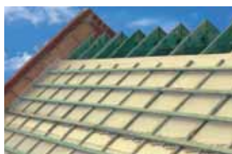
Крыши с двухслойной вентиляцией.
