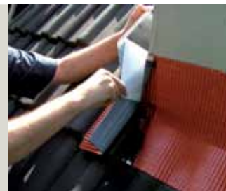
Рулон из окрашенной свинцовой ленты для устройства примыканий кровельного материала к стенам и трубам.
