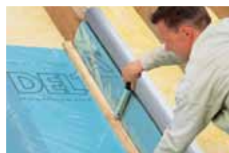
Пароизоляционная плёнка для санирования крыш.
