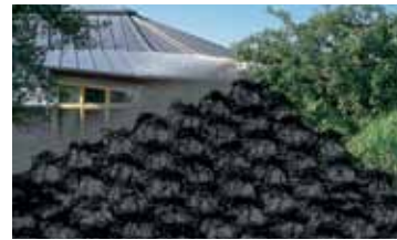
Крыши с фальцевой и штучной металлической кровлей.
