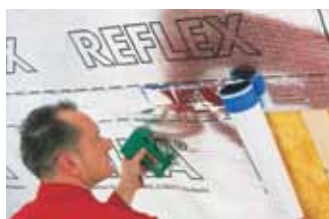
Пароизоляционная плёнка для скатных и плоских крыш.
