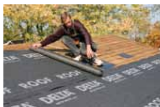
Подкладочный ковёр под битумную плитку.
