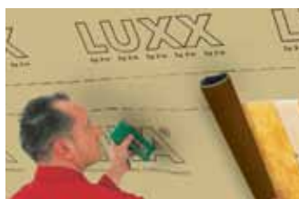
Пароизоляционная плёнка с ограниченной диффузией пара.
