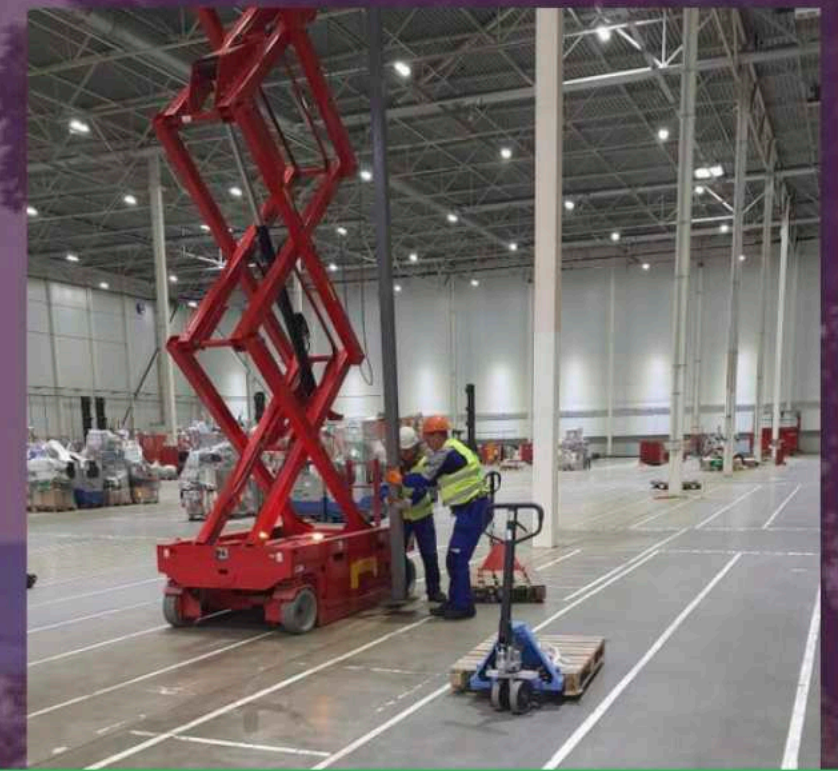
РЕКОНСТРУКЦИЯ СКЛАДА «РУЛОГИСТИК»
