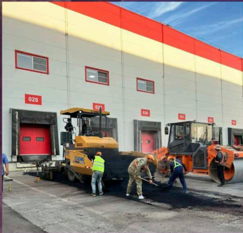
ЯМОЧНЫЙ РЕМОНТ СКЛАДСКОГО КОМПЛЕКСА
