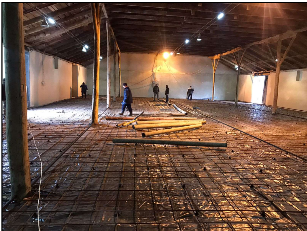
Капитальный ремонт склада по адресу: Краснодарский край, г. Тихорецк
