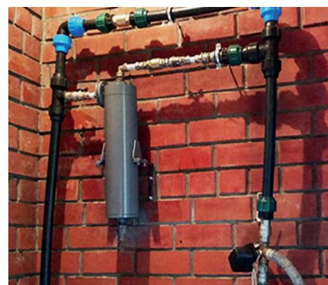
СОВ-1ВП выполнен из нержавеющей стали «пищевого» класса, препятствуя размножению бактерий внутри корпуса
