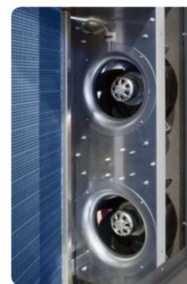
На всех моделях линейки **NRC** в серийной комплектации установлены теплообменники с гидрофильным покрытием ламелей. Наличие особого покрытия вместе с правильной скоростью прохождения потока воздуха способствует сбору конденсата в процессе удаления влаги, предотвращая срыв и унос капель с теплообменника.
