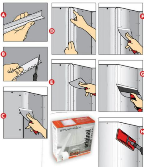
Измерьте высоту стены и отрежьте ORIGINAL на 10мм меньше с помощью ножниц или ножа.
