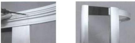
Используйте 16 самонарезающих болтов, чтобы прикрепить к двум опорным стойкам и к дугообразным направляющим. Вставьте гребни уплотнения в зазор между неподвижным стеклом и опорными стойками.
