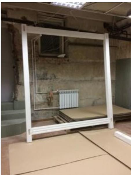
7. Вставить при помощи продольного усилия рук доску фасадную нижнюю боковую поз.2 и доску верхнюю фасадную боковую поз.4 в пазы опор поз.1 согласно схемы и Фото 5. И Фото 6. Предварительно промазать тонким слоем силиконовой смазки поз. 19. стенки пазов на опоре и шпунтов на фасадной доске.
