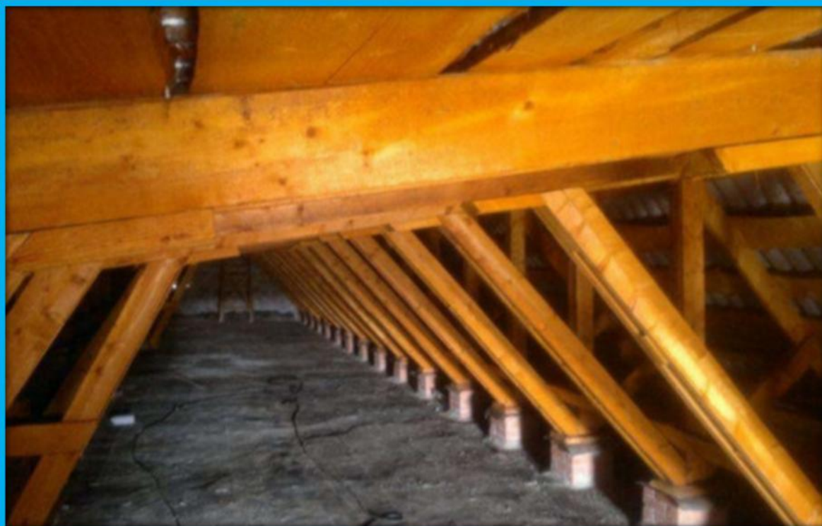
Стропила обработаны огнебиозащитой
