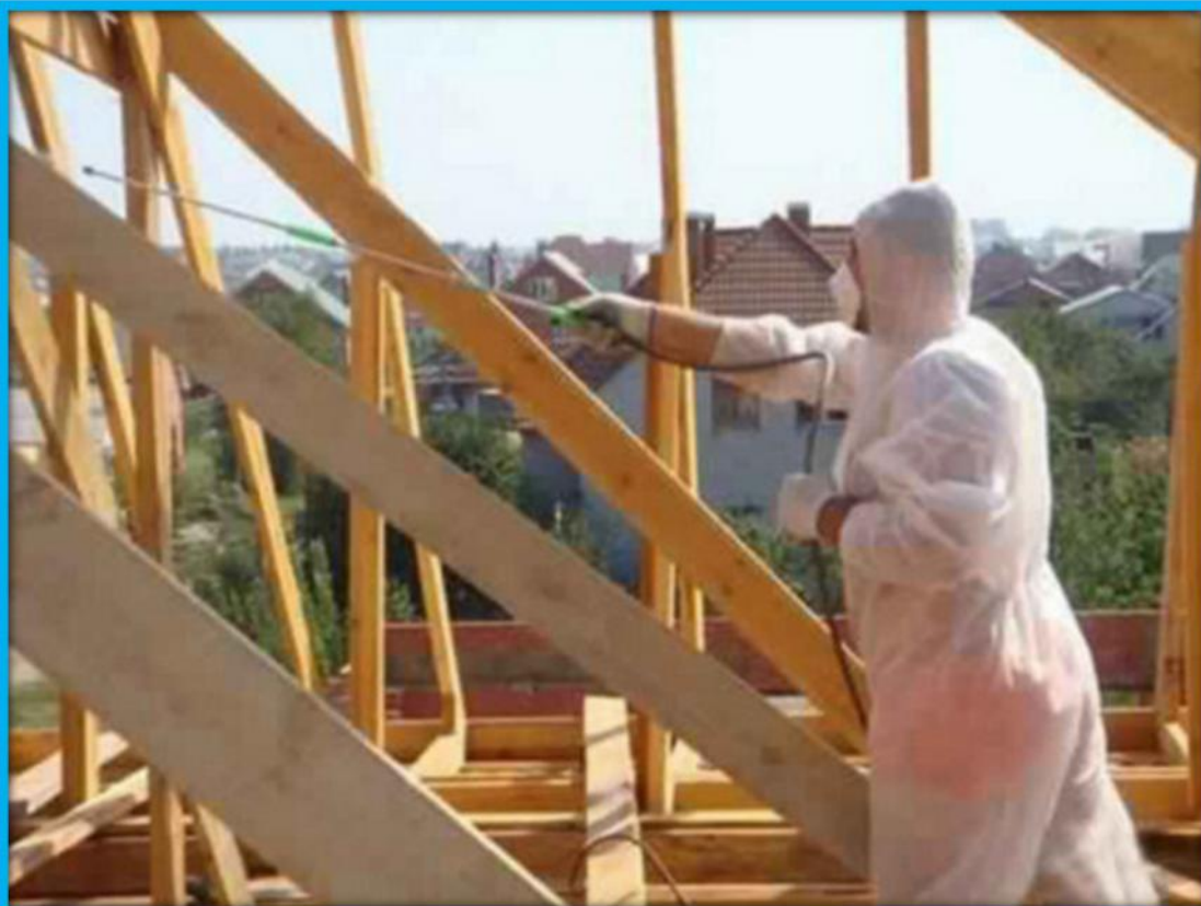
Обработка во время строительства
