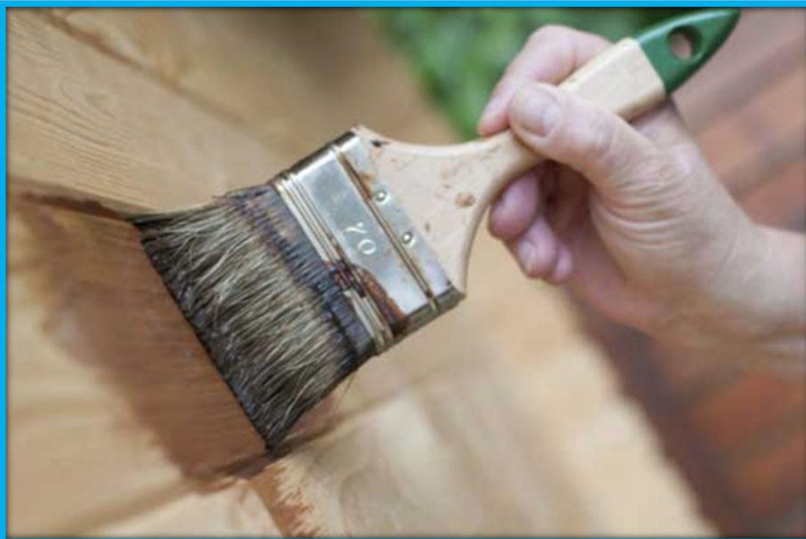
Ручное нанесение состава
