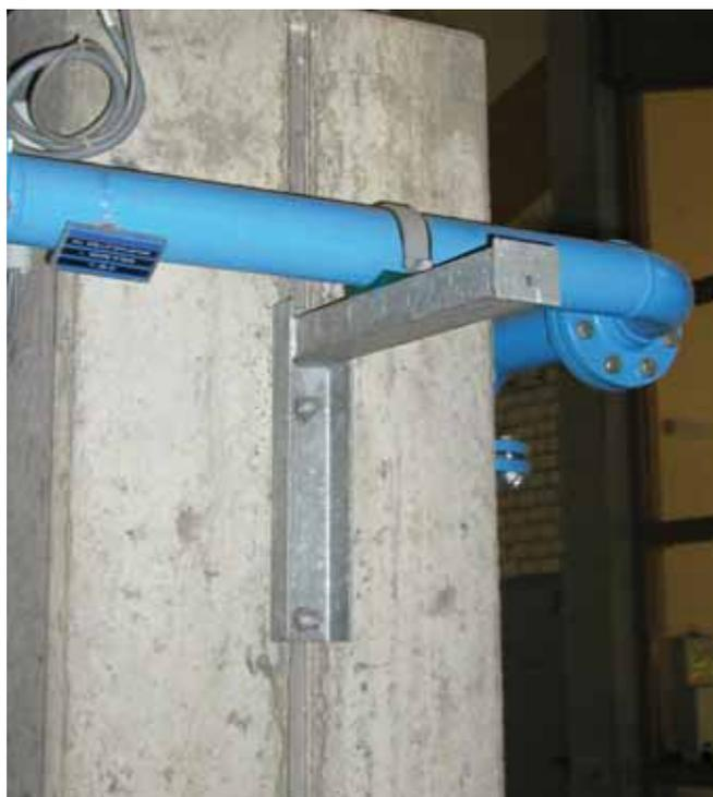
Регулируемая опора для труб, кантилевер с вертикальной зубчатой шиной
