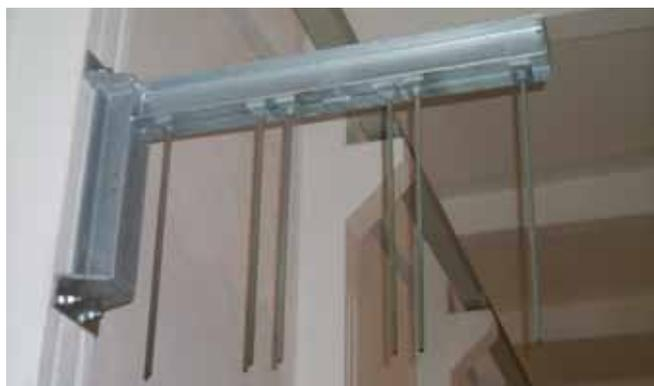
Кантилевер для поддержки труб, монтированных к вертикальным зубчатым шинам
