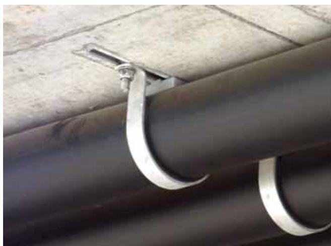
Опора для труб, монтированная болтами к потолку
