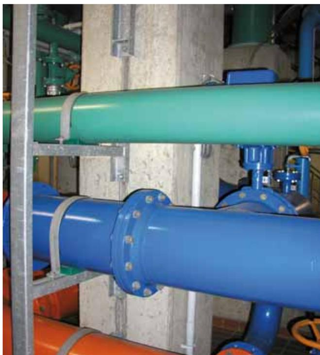
Опора для труб, монтированная при помощи вертикальной шины
