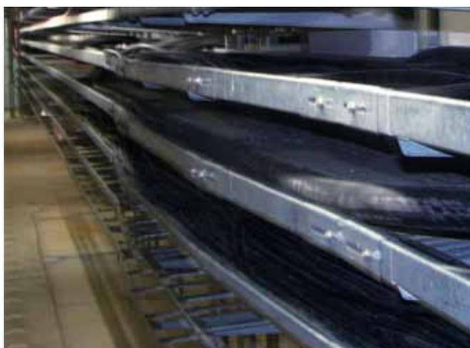
Кабельный желоб выровнен монтажем к вертикальным зубчатым шинам
