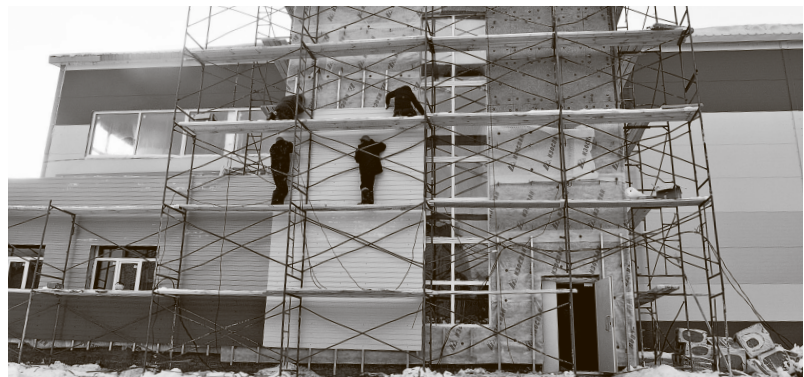
В здании физкультурно-оздоровительного комплекса в Сузуне, по словам Евгения Покровского, идут отделочные работы, в течение января-февраля будет проверка функционирования всех систем. Требования к такого рода объектам сейчас жёсткие, и не соблюдать их нельзя.
