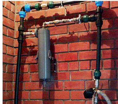
СОВ-1ВП выполнен из нержавеющей стали «пищевого» класса, препятствующей размножению бактерий внутри корпуса
